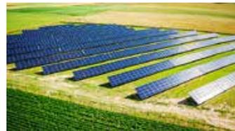
Hier ein Bild mit Freiland-PV in klassischer Südausrichtung und unbeweglich montierten Modulen. Werden die oben besprochenen Kriterien eingehalten, kann eine AGRI-PV tatsächlich auch so aussehen.
