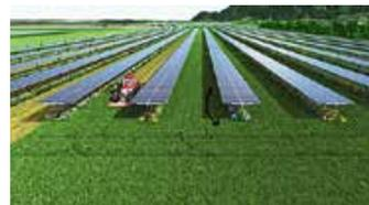
Hier eine AGRI-PV in Nord / Südausrichtung. Bei der abgebildeten Anlage können die Module mit dem Sonnenlauf von Ost nach West gekippt werden. Die Aufständerung kann je nach geplanter Maschinenbewirtschaftung oder Größe der Tiere
